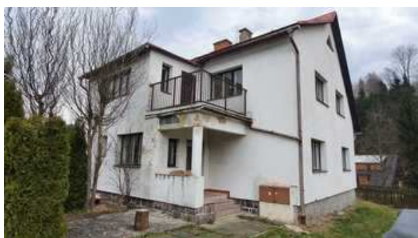
Pohled u vstupu
