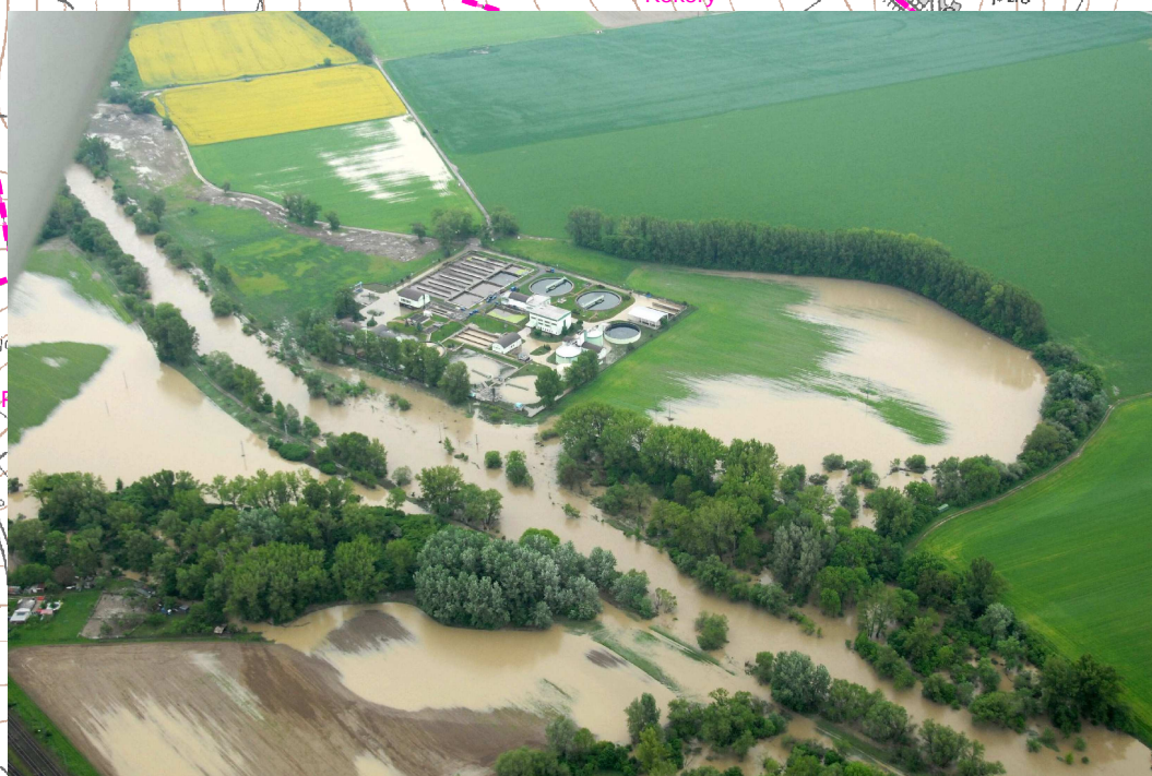
19.5.2010 ČOV Dluhonice po opadnutí povodně
